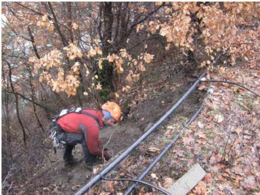
Operazione di pulizia della nicchia di distacco
